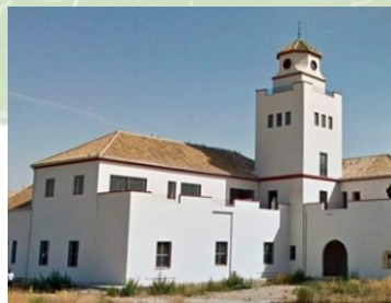
EDIFICIO P8 GRANADA
