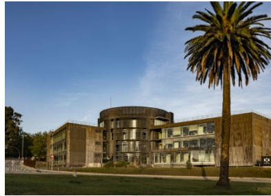
EDIFICIO TECNOLÓGICO P11
